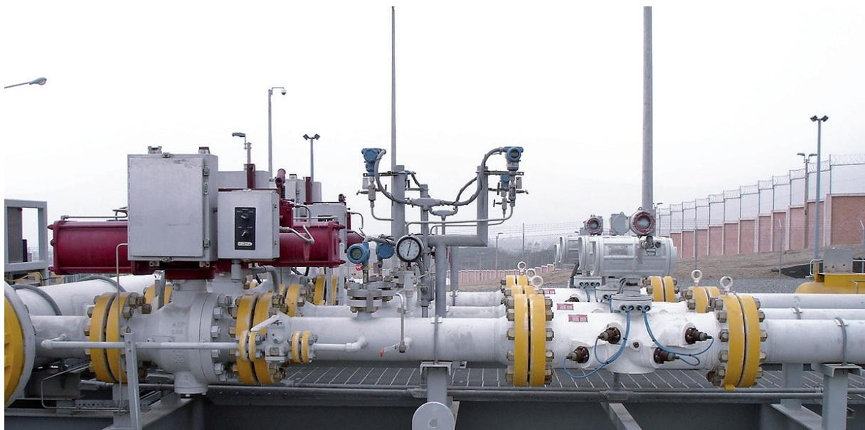
Las bajas temperaturas pueden controlarse mediante el intercambio calórico en las estaciones de reducción de presión. Puede hacerse mediante equipos sencillos de intercambio con la atmósfera (tipo radiador) o usando alguna fuente de calor, como pueden ser intercambiadores de calor que reciban agua caliente o vapor de agua, o algunos equipos que operan por convección gracias a quemadores operados por el mismo gas.
